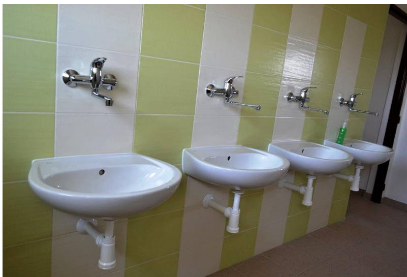
Nově zrekonstruované sociální zařízení v nové budově školy.
